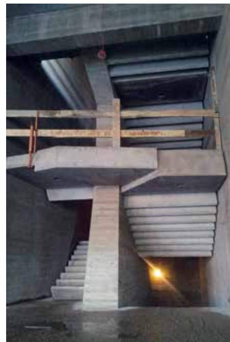
Prefabrykowane „zębate” schody w budynku nr 3.
