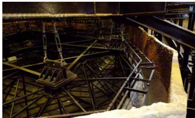
Stalowa konstrukcja nośna jednego z paneli akustycznych – widok z góry (od strony pomostu technicznego)
