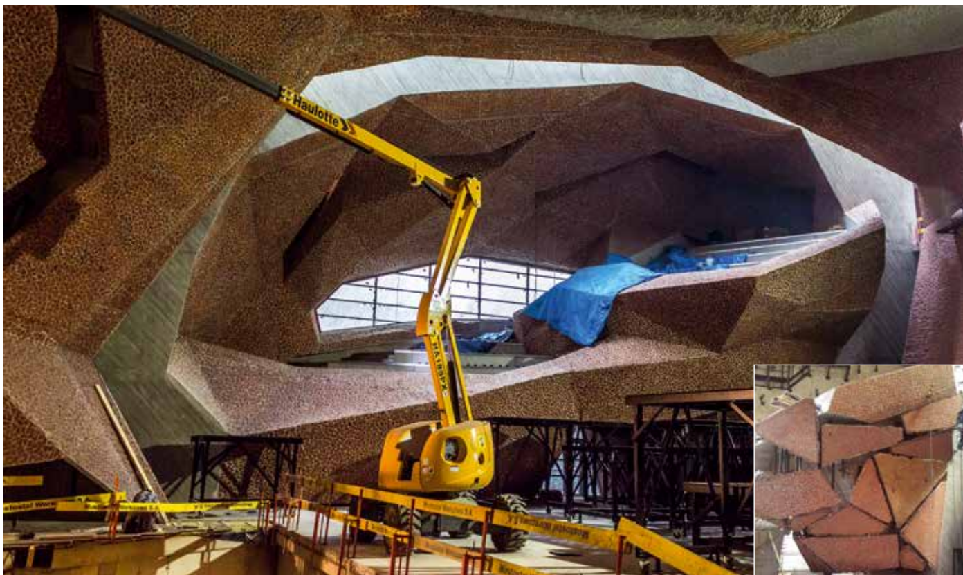
Widownia boczna od strony głównej sali koncertowej. W prawym górnym rogu można zauważyć fragmenty dwóch z pięciu paneli akustycznych. W prawym dolnym rogu zdjęcie z etapu montowania okładzin pikado widowni bocznej do podkonstrukcji stalowej.
