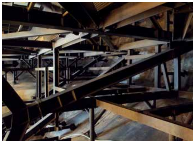
Fragment podkonstrukcji stalowej pikado w budynku trzecim (nad widownią główną).
