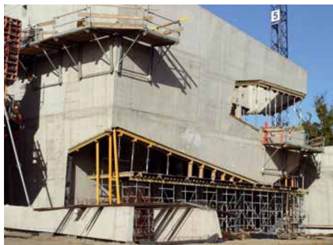
Elewacja wschodnia budynku trzeciego w trakcie budowy.
